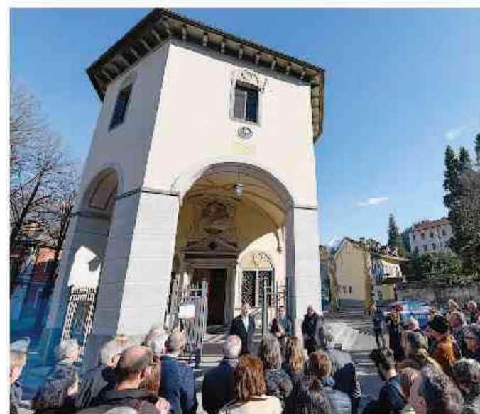
Conclusi i lavori alle pareti esterne del santuario mariano
